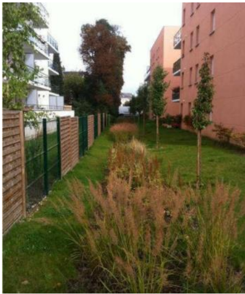
Exemple de noue de temporisation et d'infiltration (gauche) – Principe de temporisation et d'infiltration (droite) Source : Infra Services
