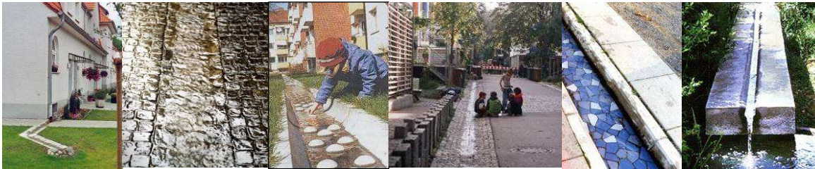
Exemples de caniveaux à Bottrop (D), Bâle (CH), Malmö(SW), Fribourg (D), Bergkamen (D)
